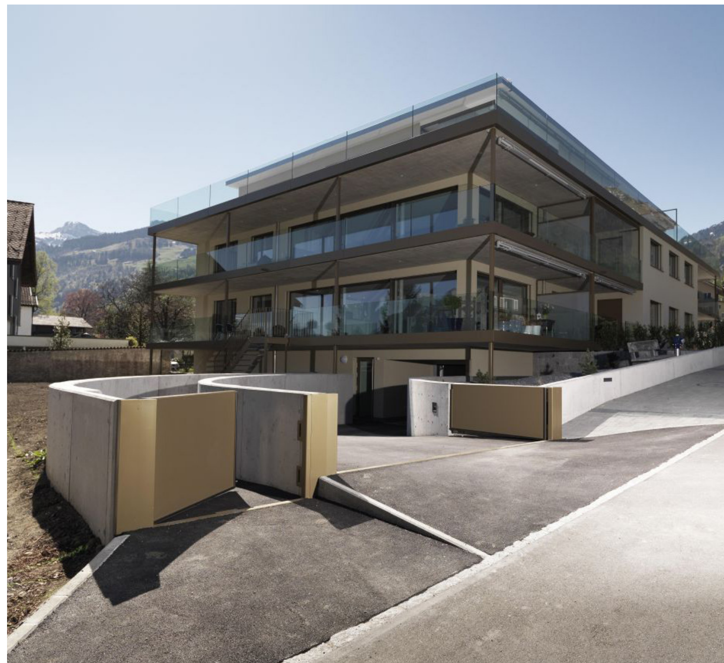
Einbau Nidwaldner Tor in Bachegg Beckenried NW
